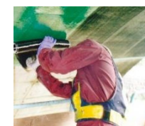
連続繊維シート補強工法
